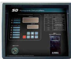
Uređaj za merenje tačke rošenja instaliran na sušač
